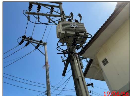
รูปที่ 2.2-4 หม้อแปลงไฟฟ้า
